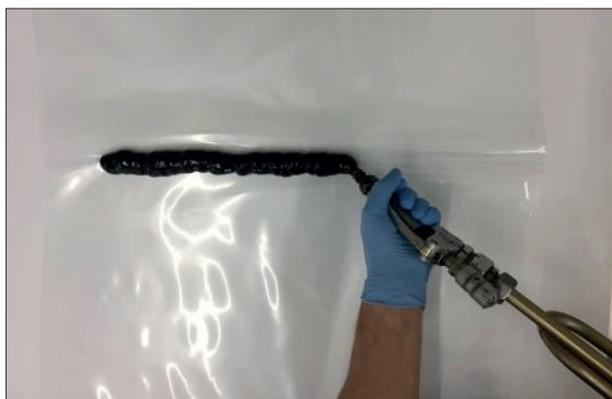
FIGURA 9 Aplique el cordón en la dirección del pliegue
