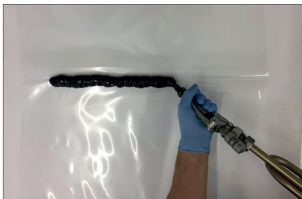
FIGURA 9 Aplique el cordón en la dirección del pliegue
